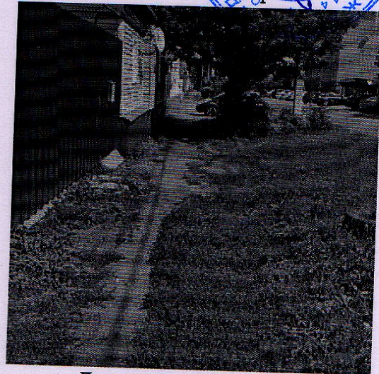
Демонтаж а/б покрытия
